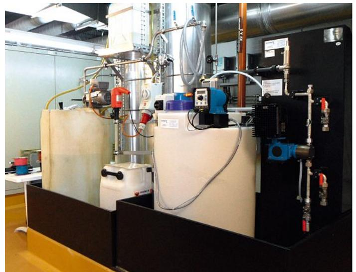
Dosieranlage Ammoniak-Dosierung für Speisewasser und Natronlauge/Trinatriumphosphat-Dosierung für Kesselwasser.
