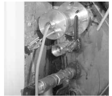
Die Aussenmontage des Mikrowellen-Messkopfs MWTS PP guard an einem Biogas-Fermenter zur Online-Überwachung des TS-Gehalts in Gärprozessen.
