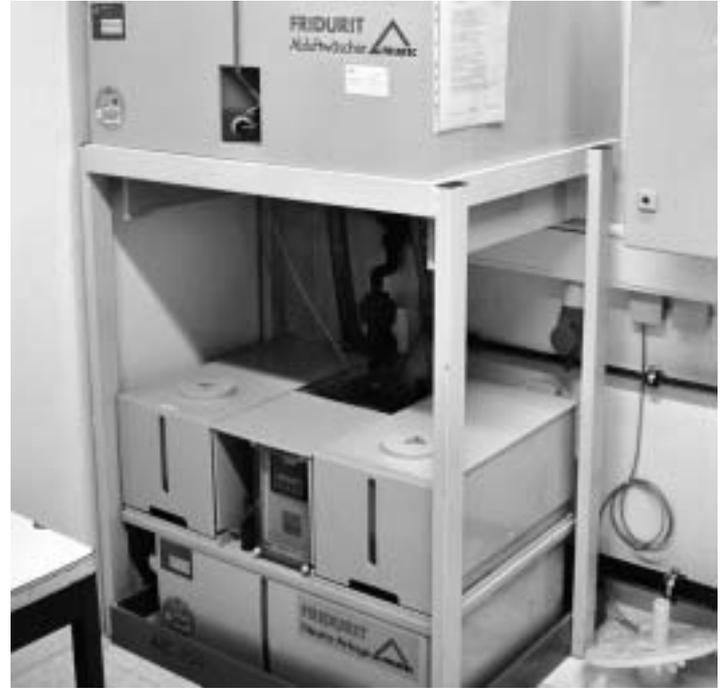
Das Labor-Abluft-Reinigungssystem besteht aus Wäscher (oben) und Neutra-Anlage (unten) sowie dem Schaltschrank (rechts). Es ist in unmittelbarer Nähe der Laborarbeitsplätze installiert.
