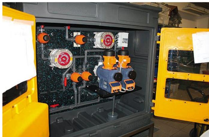
Abbildung 2: Dosierschrank für Aussenauflistung (Biogasanlage) mit zwei Dosagen inkl. Pulsationsdämpfern, zwei Druckhalteventilen und zwei Überströmventilen. (Quelle: UTEC Umwelttechnik GmbH)
